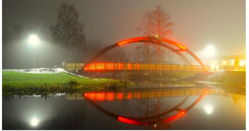
Kuva: Osmo Metsälä; Kauhajoen keskustan silta "RANTAKAARI"
